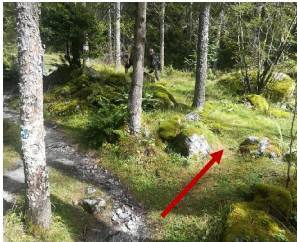
Fig. 11 – 12. Varianti lungo il percorso (bretelle accessibili) nel tratto prima di Cà di Carna, dove l'azione erosiva dell'acqua meteorica (ruscellamento) ha causato una accentuata irregolarità di questo tratto di sentiero. Operazioni previste: taglio della vegetazione invadente, spostamento di massi e posa di segnaletica.
