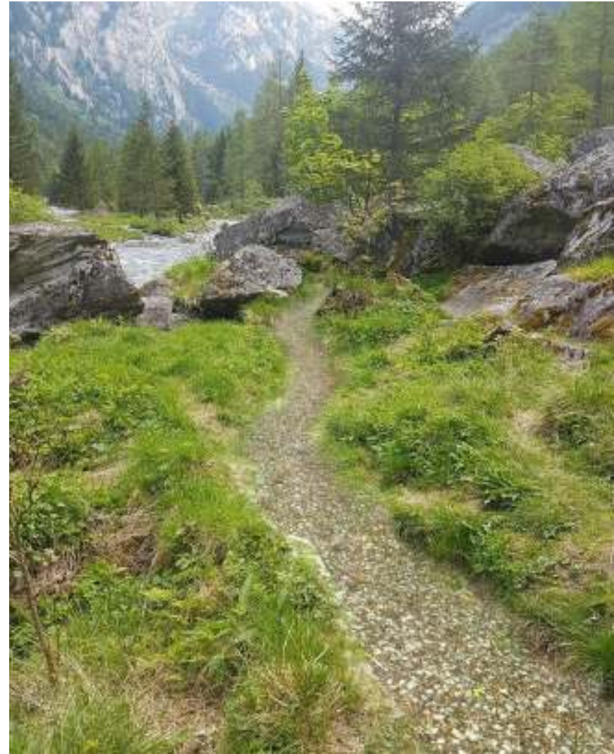
Fig. 35 – 36. Località Cascina Piana. Stato di fatto e di progetto (rendering). Forte erosione del sentiero da parte del torrente Mello con formazione di solchi percorsi dall'acqua. Manutenzione del sentiero mediante ricarica con materiale idoneo e protezione spondale (vedi figure successive).
