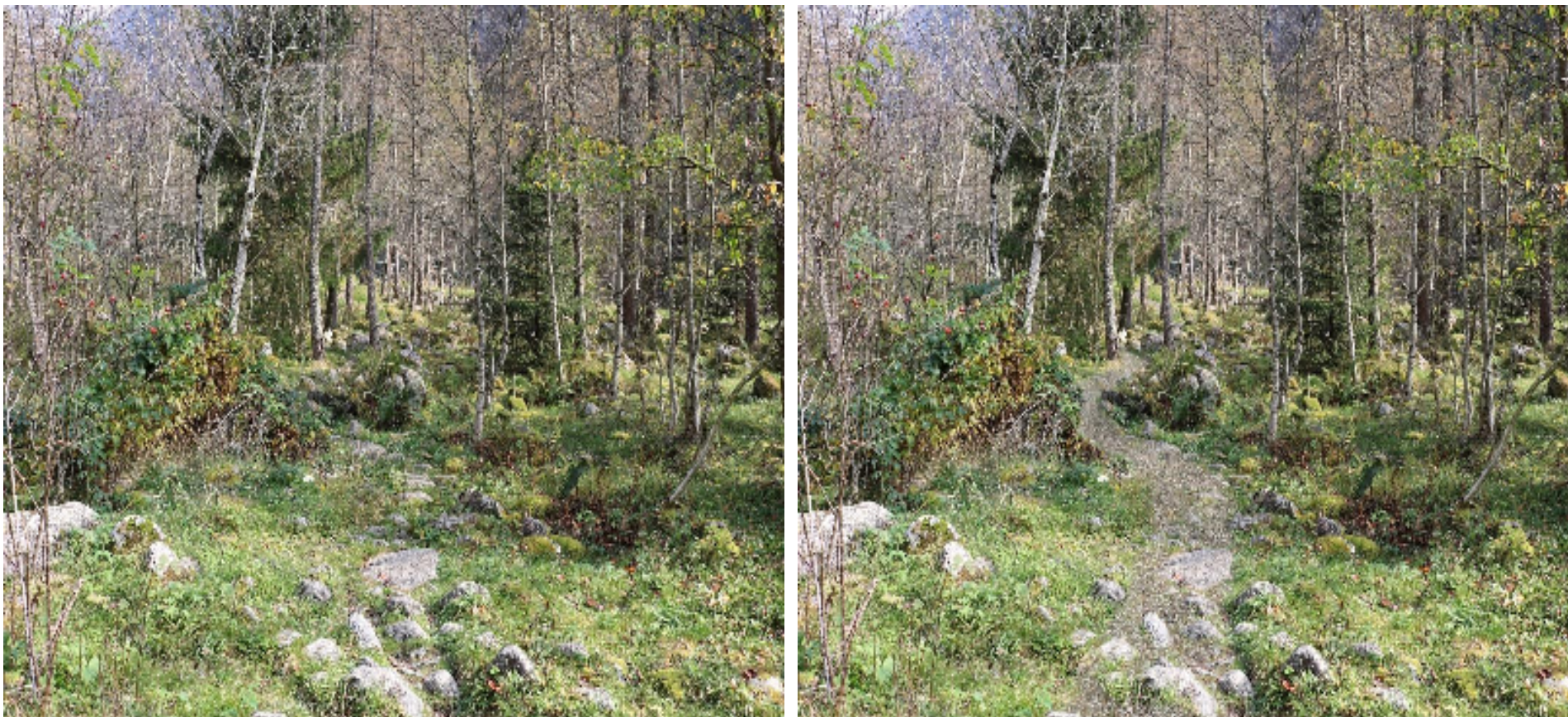
Fig. 3 – 4. Stato di fatto e di progetto (rendering). Operazioni di taglio della vegetazione e di adeguamento della sezione, per avere in tutti i punti del sentiero una larghezza minima di 0.90 cm mediante movimento terra con mini escavatore (operazioni di sterro e riporto) consistente nella rimozione del cotico erboso e regolarizzazione del fondo.
