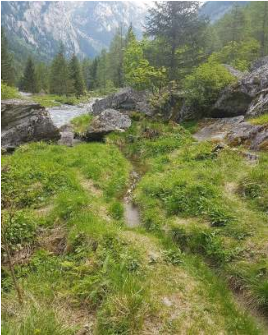
Fig. 35 – 36. Località Cascina Piana. Stato di fatto e di progetto (rendering). Forte erosione del sentiero da parte del torrente Mello con formazione di solchi percorsi dall'acqua. Manutenzione del sentiero mediante ricarica con materiale idoneo e protezione spondale (vedi figure successive).
